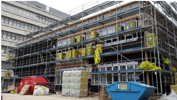
Bild 5 – Außenansicht von West
