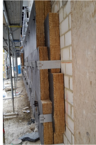
Bild 6 – UK und Dämmung
