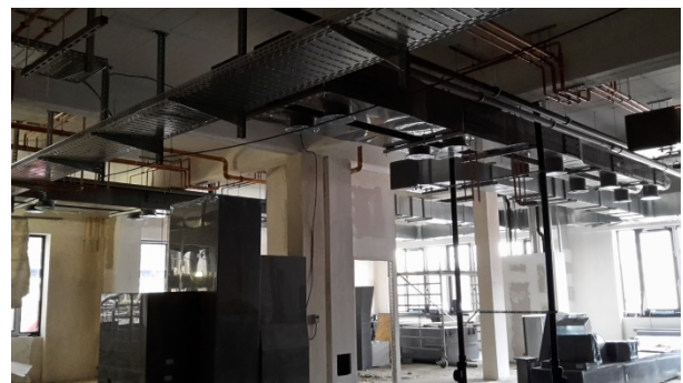
Bild 2 – Kanalverlegung Praktikum, Ebene 0
