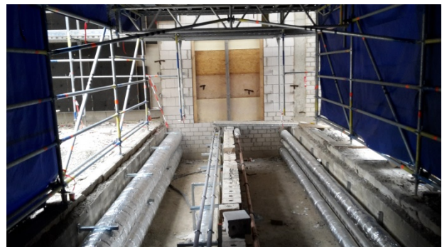
Bild 4 – Verbindungskanal von Innen
