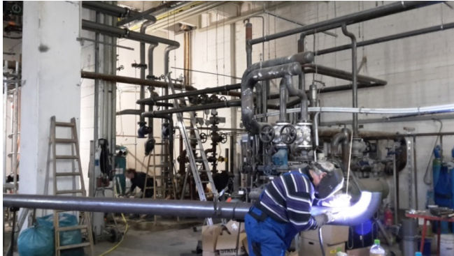
Bild 8 – Montage an der Heizungsanlage
